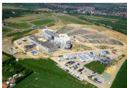
Terrassement, VRD, abords des parkings de la Polyclinique de Divion
